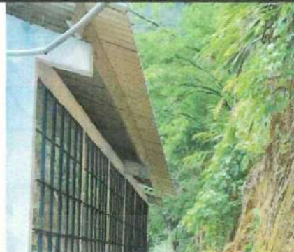
Foto 2: Se observa la necesidad de colocar canales para bajada de agua pluvial
