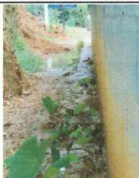
Foto 5: Se observa la necesidad de cernir las paredes del establecimiento educativo para evitar filtraciones de agua y humedad
